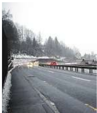
Das schmale Trottoir auf der H8 wird ausgebaut.
