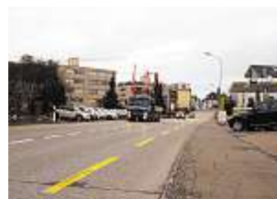
Die Kantonsstrasse in Freienbach soll optisch verengt werden.
